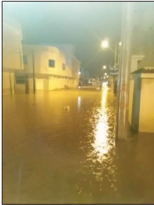
Photo.6.1 : Habitations inondées à la ville de Kairouan au niveau de la route nationale n° 2 vers Haffouz le 30-09-2015.
