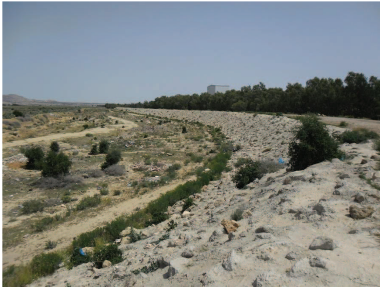
Photo.10.3. Digue de protection Nord à Sidi Bouzid. Photo prise par (Nasrallah Wafa., le 24-04-2017)
