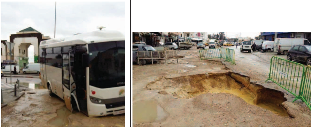
Photo.6.8 : L'évènement pluvieux du 16 décembre 2016 (Quartier « El Hajjam » - Ville de Kairouan)
