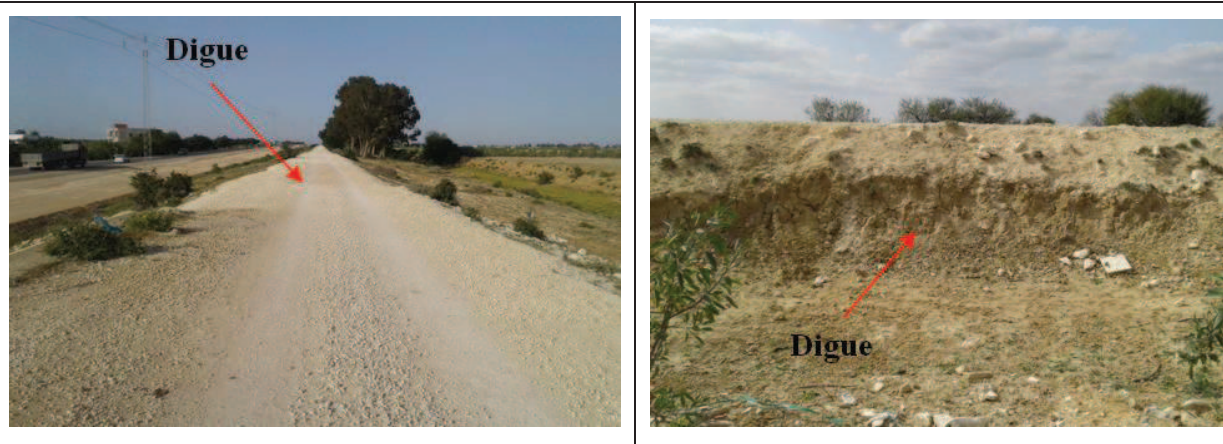
Photo.10.1 : Digue de protection de la ville de Kairouan. Clichés Nasrallah Wafa, le 24/04/2017
