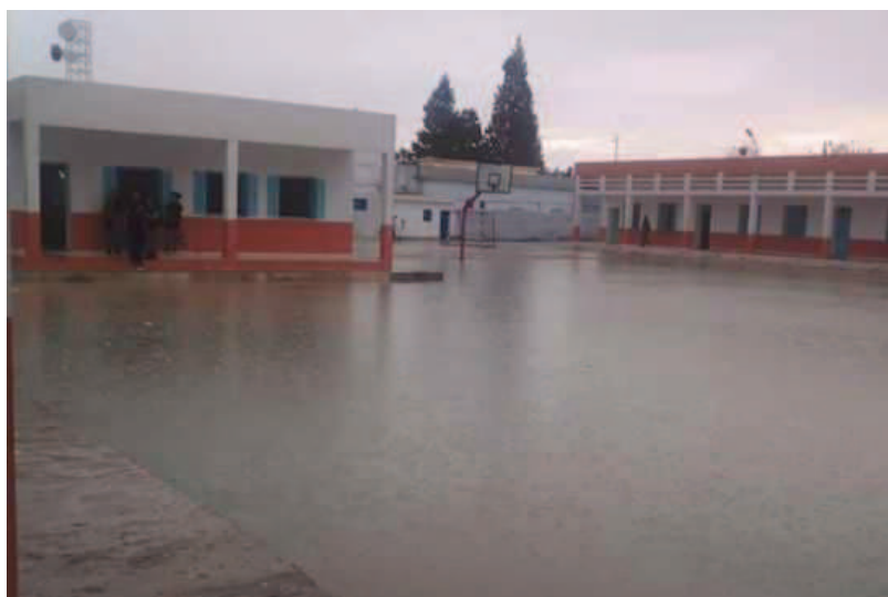
Photo.6.9 : L'évènement pluvieux du 05 octobre 2017 (Lycée Chedli Atallah- Rue de Fès- Ville de Kairouan)
