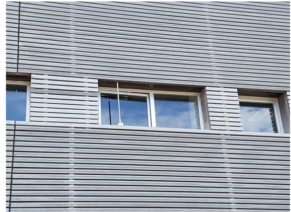
(d) Roadside ITS-S antenna.
