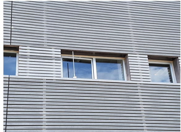
(d) Roadside ITS-S antenna.
