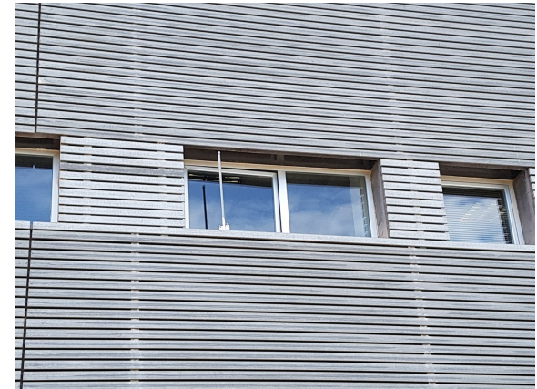
(d) Roadside ITS-S antenna.
