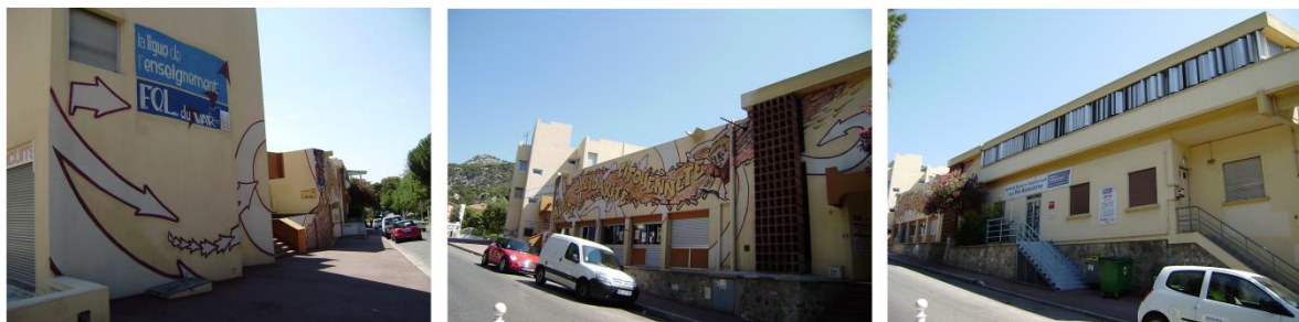
Figure 46. Façade de la fédération du Var
