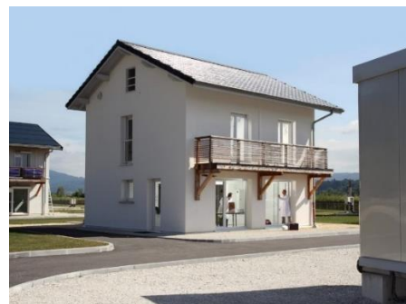
Figure III. 4 - Plateforme expérimentale INCAS, sur le site INES
