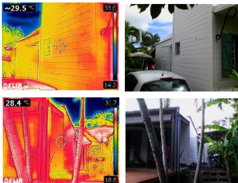
Figure 2- 30: Images thermiques façade Est (à gauche) - photo des lieux (à droite)
