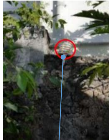
Abri ventilé Extérieur Est
