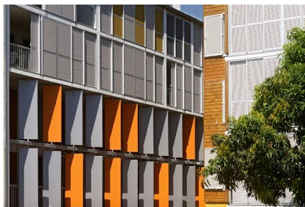
Figure 3- 11: Façade Sud Sud Ouest bâtiment A – Ilet du centre - © H Douris
