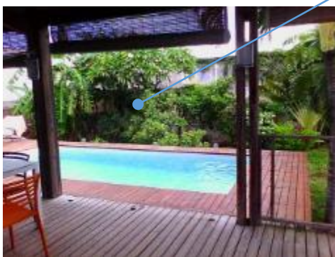
Abri ventilé Extérieur Sud
