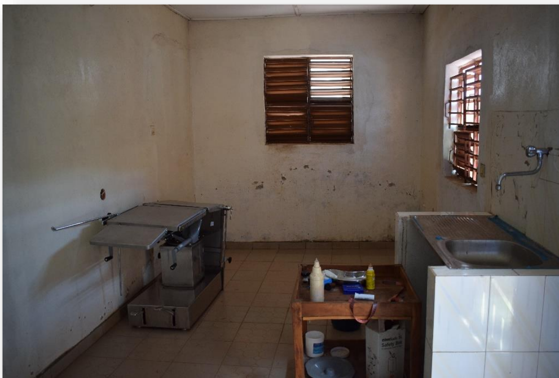
Fig.28 : Salle d'accouchement, centre de soin de Sègbédji (Abomey – quartier d'Houndjroto) 229 .
