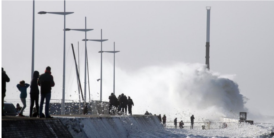
Figure I.1.3: Tempête Eleanor touchant la digue Nord du Havre, provoquant des débordements de bassins dans les quartiers de Saint-François et du Commerce de la ville (source : paris-normandie.fr)
