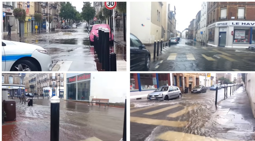
Figure I.1.4: Débordements à différents endroits du réseau d'évacuation des eaux pluviales au Havre le 10 août 2014 (source : youtube.com/driverhavre)
