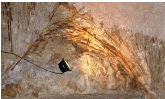
Figure 1 : Coffrage d'une voûte à l'aide d'une structure en roseaux sous la Villa Medici à Rome. Veenendaal et al., 2011 11
