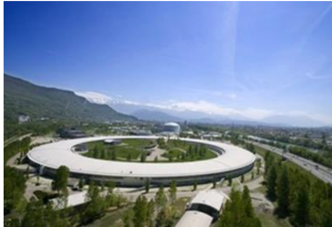
Figure 2-10 : ESRF à Grenoble
