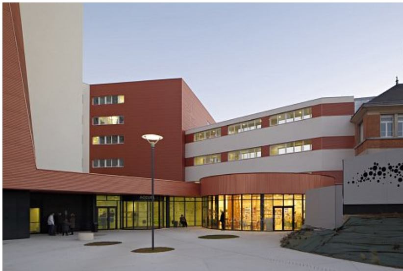
FIGURE 1.1 – L'entrée du nouveau bâtiment du CHT
