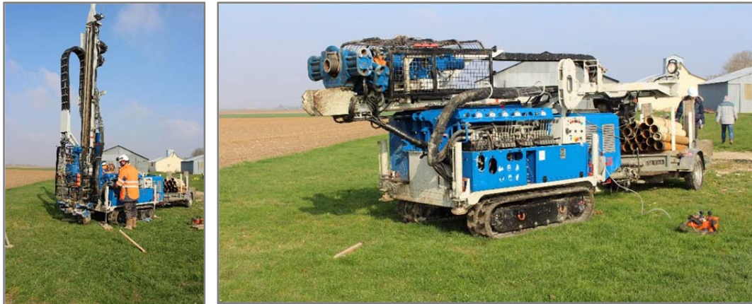
Figure 10- 2 Machine foreuse pour la réalisation des puits sur le site d'étude à Villamblain.
