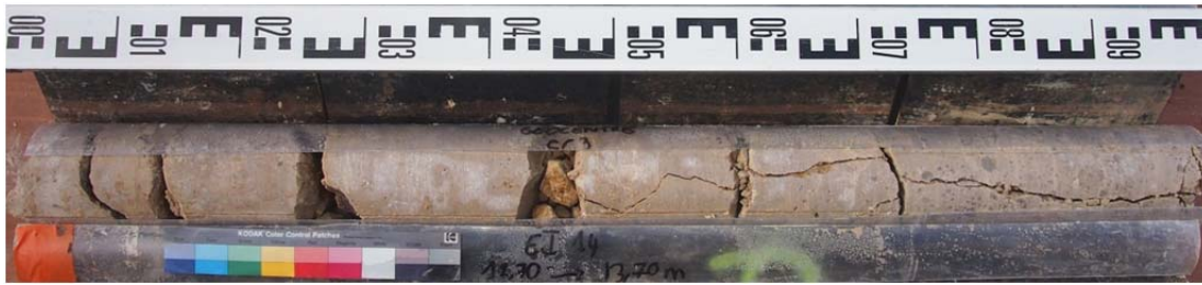
Figure 11- 14 Roche calcaire saine avec des fractures (12,7-13, 7 m-SC3).
