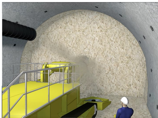
FIGURE 6.9: Le creusement de la route par la MAP
