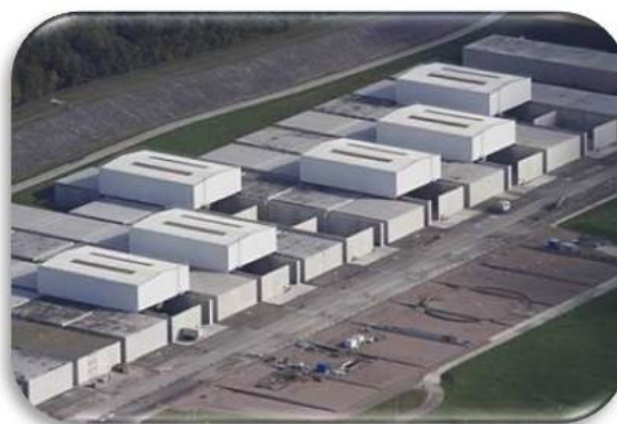
FIGURE 1.8: Le centre de stockage de faible et moyenne activité de l'Aube
