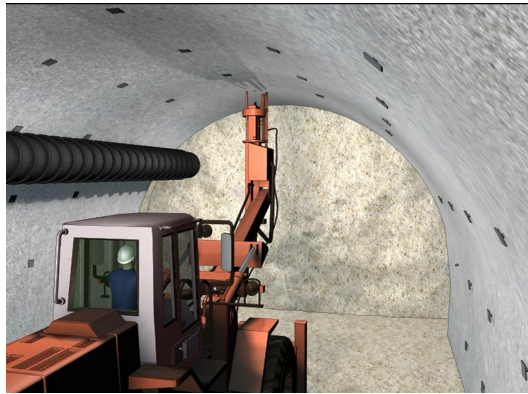
FIGURE 6.16: La mise en place des boulons
