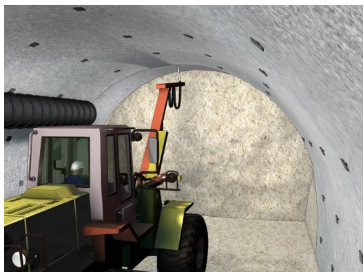
FIGURE 6.15: La mise en place du béton projeté
