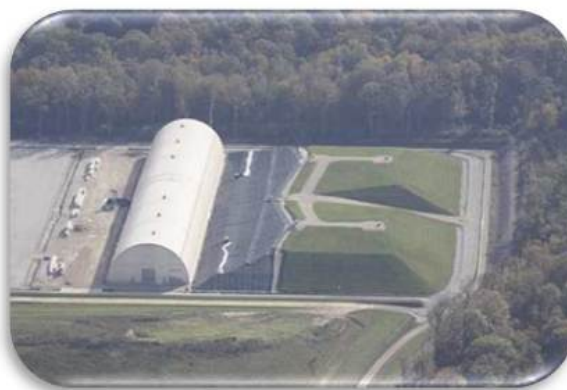
FIGURE 1.7: Le centre de stockage de très faible activité de l'Aube
