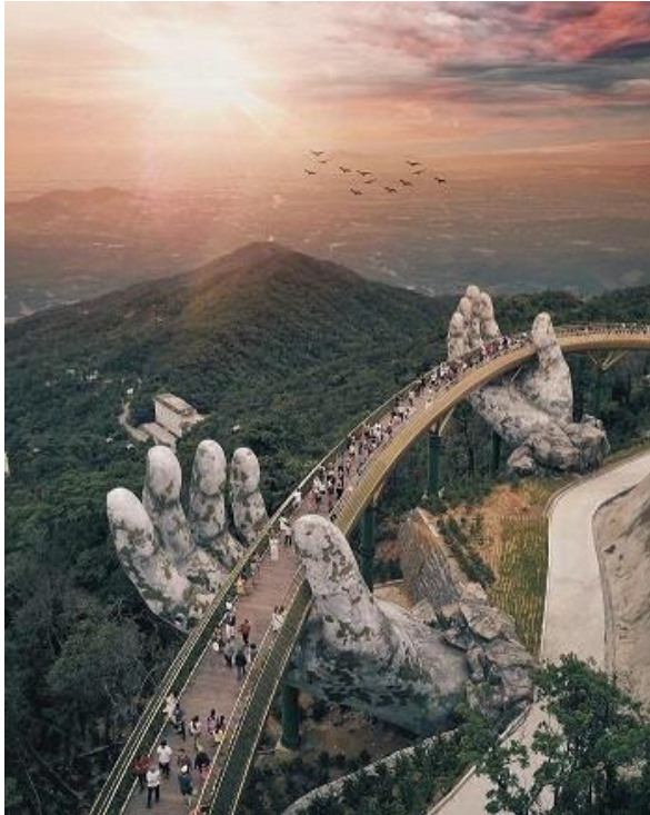
Photo 1.44 : le Pont d'Or de Da Nang, construit en 2015 - un extrémisme du Kitsch Cliché : GOH, J., 2015
