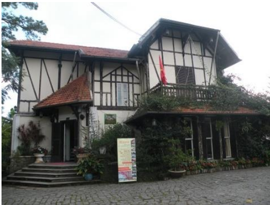
Photo 2.40-2.41 : Villa coloniale de style Normand à colombage à Dalat avec façade à l'extérieur et l'intérieur. L'ensemble des poutres formant la charpente du mur, cette ossature de bois a pour rôle de soutenir la maison (Valentin, 2014)
