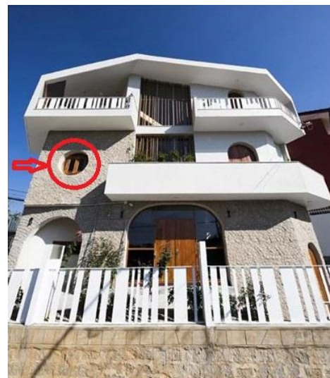
Photo 2.52: La façade classique Source : Truong An Architecture , 2019
