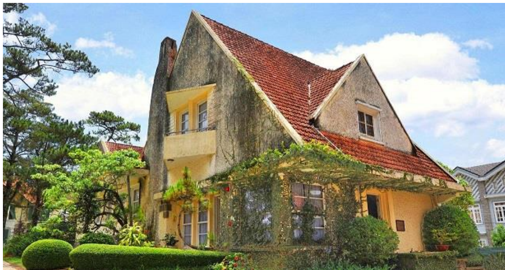
Photo 2.42: Villa coloniale de style Breton à Dalat, avec les pignons et les lucarnes triangulaires, le sommet du toit est très aigu et relié à la cheminée
