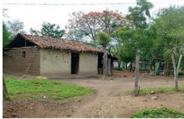
Maison de terre
