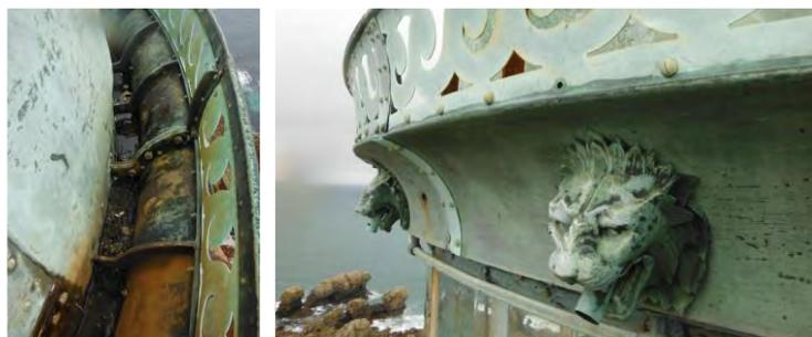
Figure 11 Chéneau et gargouilles de la lanterne. Vue extérieure [6].
