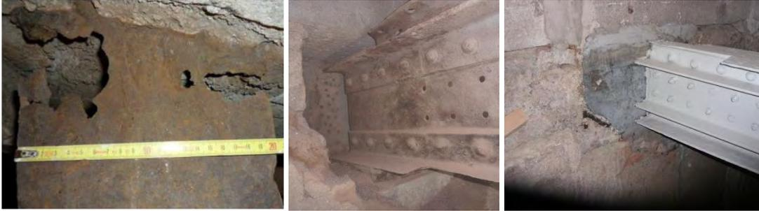
Figure 19 Poutres métalliques du plancher de la chambre de lanterne. Encastrement avant, durant et après réparation – Photo CEREMA
