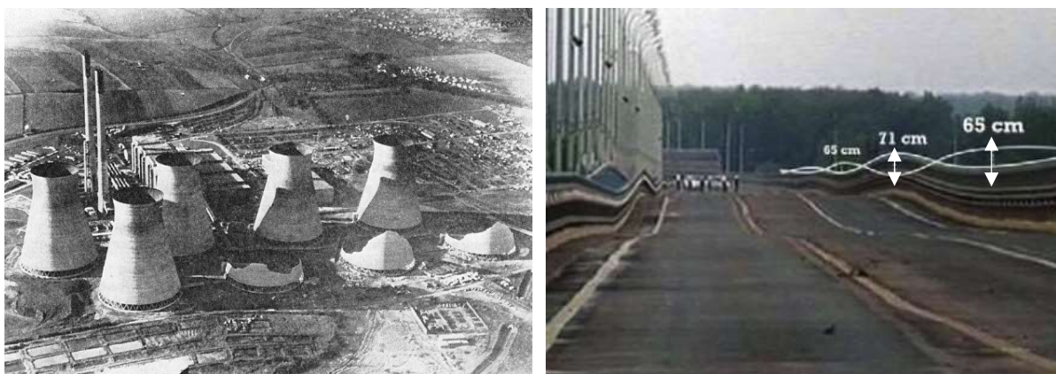
Figure 23. A gauche effondrement des tours de refroidissement à Ferrybridge (1965) reproduit de [15], à droite oscillations verticales du pont de Volgograd (2010) reproduit de [14]
