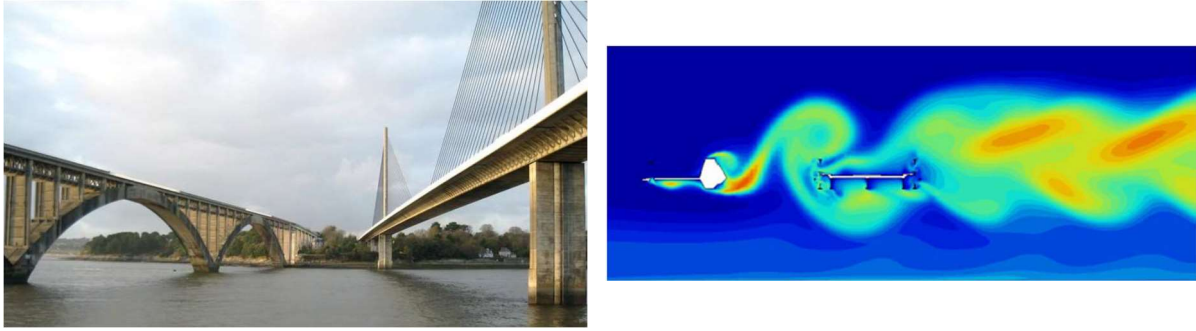
Figure 9. L'influence d'une structure voisine (© Bouygues TPRF / Optiflow)
