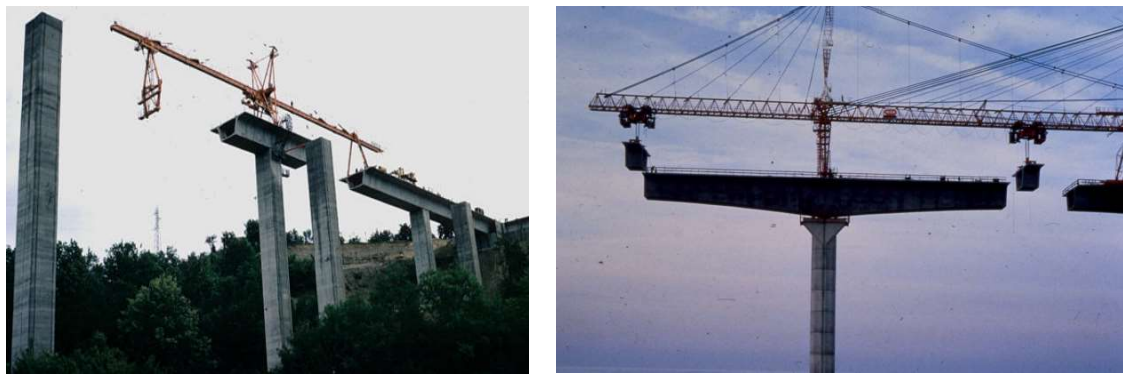
Figure 56. Quelques ponts construits par encorbellements successifs
