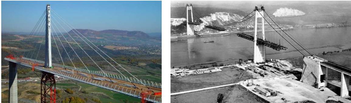
Figure 55. A gauche la construction du tablier du viaduc de Millau; ici en équilibre sur une palée provisoire (copyright photothèque Terra). A droite la construction du pont de Tancarville
