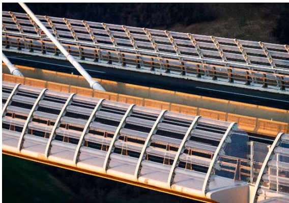
Figure 16. Influence des dispositif de retenue du viaduc de Millau sur l'allure du coefficient de portance. (vent moyen) ; en service : avec dispositif de sécurité ; en construction : tablier nu
