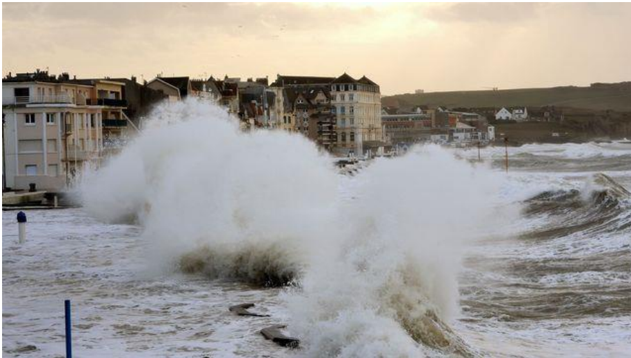
Digue Nord de Wimereux, Pas-de-Calais, un jour de tempête 2014 (source : L'Express)
