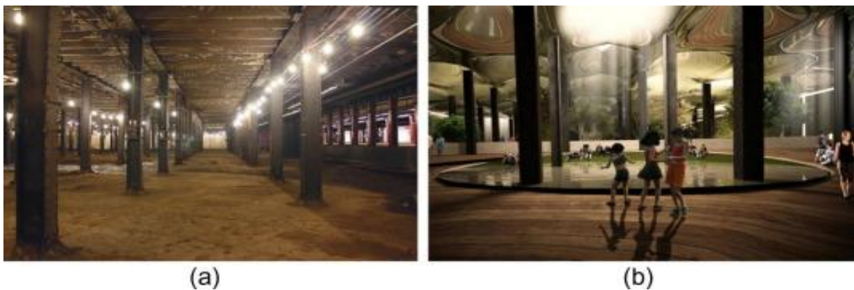
Figure 24 : Projet "LowLine" NewYork - USA, (A) avant (B) après [Labbé, 2016]
