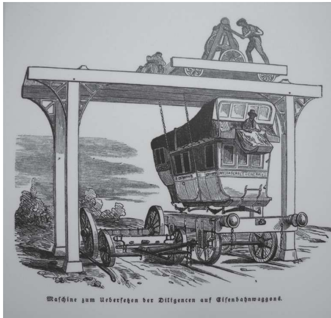
Figure 33 - Maschine zum Übersetzen der Diligencen auf Eisenbahnwaggons [Machine pour transposer une diligence en wagon de chemin de fer], Illustrierte Zeitung , tome 2, n°50, Leipzig, 1844. Illustration dans un journal allemand du transbordement d'une diligence Caillard & Cie sur un chemin de fer.
