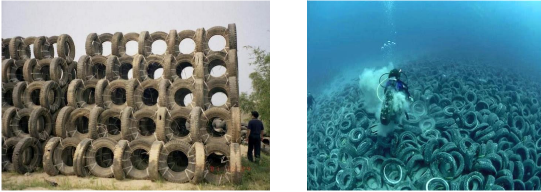
Figure I-6 :Illustration de récifs artificiels réalisés à partir de pneus : a) projet Tire Artificial Reefs (TAR) immergés en 1997 à Hong Kong (source : https://www.maoandpartners.com/tyre-artificial-reefs/ ), b) pneus immergés dans les années 1970 à Fort Lauderdale (Floride) dans le but de créer un récif artificiel (source : http://www.geologyin.com/2015/10/floridas-tire-reef-has-turned-into.html )
