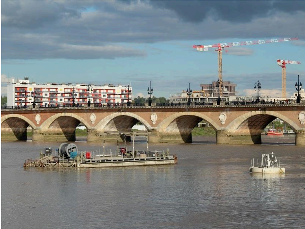
Figure 44. La plateforme flottante d'hydroliennes Seeneoh utilise les arches du pont de pierre de Bordeaux pour maximiser la puissance des hydroliennes submergées dans la Garonne. Cliché de l'auteur, 2019.
