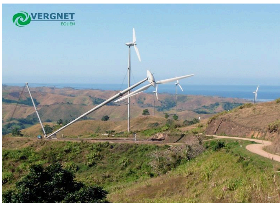
Figure 28. Les éoliennes rabattables Vergnet ont résisté à l'ouragan IRMA. Crédit photo Vergnet.
