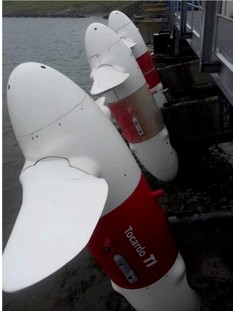
Figure 42. Les turbines T1 de Tocardo relevées pour la maintenance. Cliché de l'auteur, 2016.
