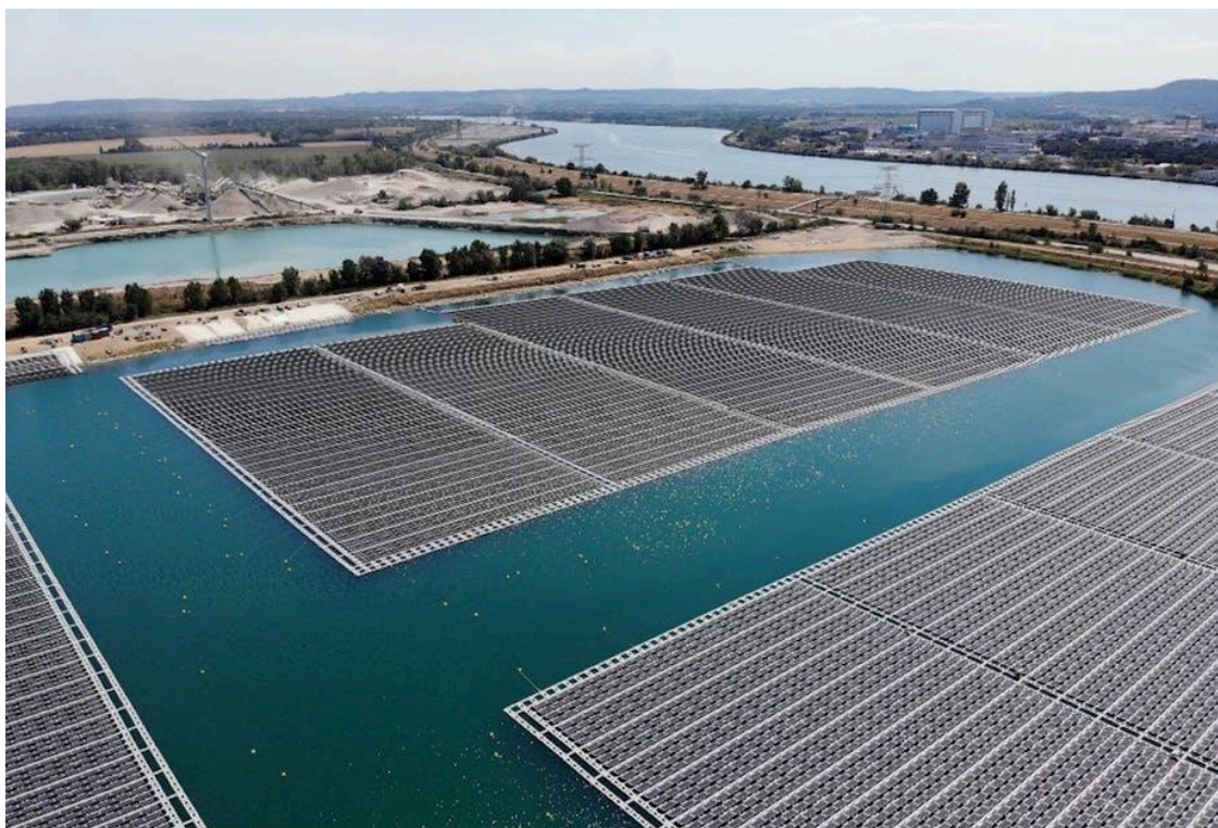
Figure 45. En septembre, la première centrale photovoltaïque flottante de France sera opérationnelle à Piolenc, dans le Vaucluse, 2019. Cliché de Gérard Julien pour l'AFP.
