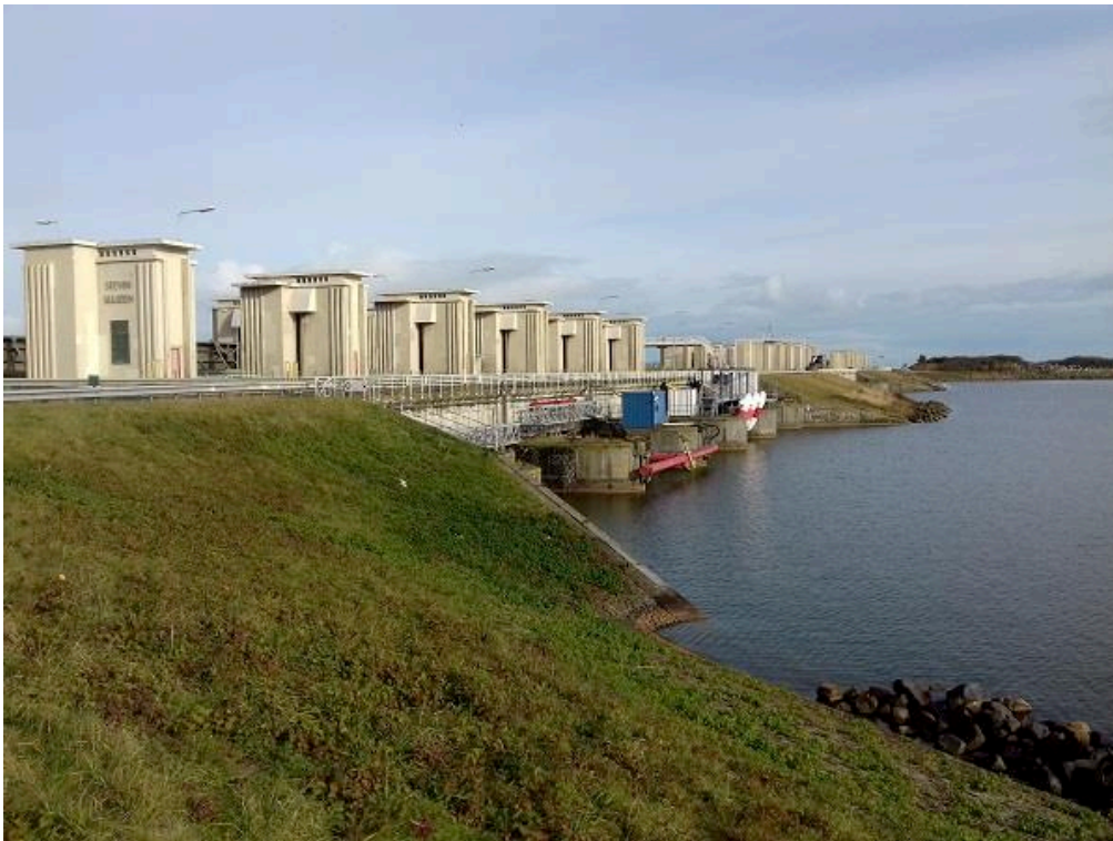
Figure 41. Les hydroliennes T1 de Tocado installées sur les écluses de la digue d'Afsluitdijk. Cliché de l'auteur, 2016.
