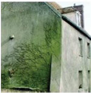
Figure I.25 – Bioaltération d'une façade [DALO15]
