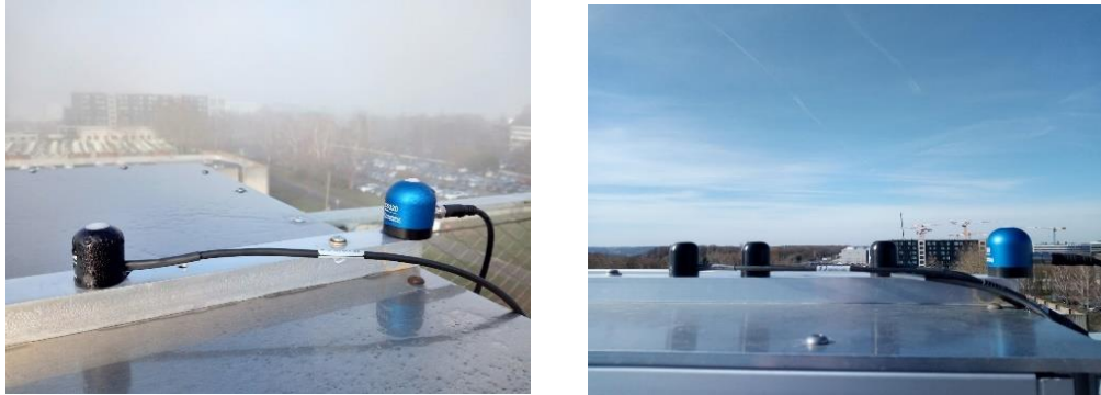
Figure 140 Installation des pyranomètres pour calibration
