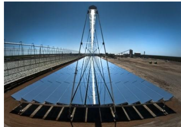
Figure 8 Fonctionnement d'un concentrateur à miroirs de Fresnel [19], [21]
