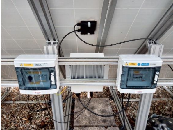
Figure 70 Vues des coffrets DC et AC, situés à gauche et à droite, respectivement, de l'onduleur et de la centrale d' acquisition Campbell sur la figure de droite (Février 2019)
