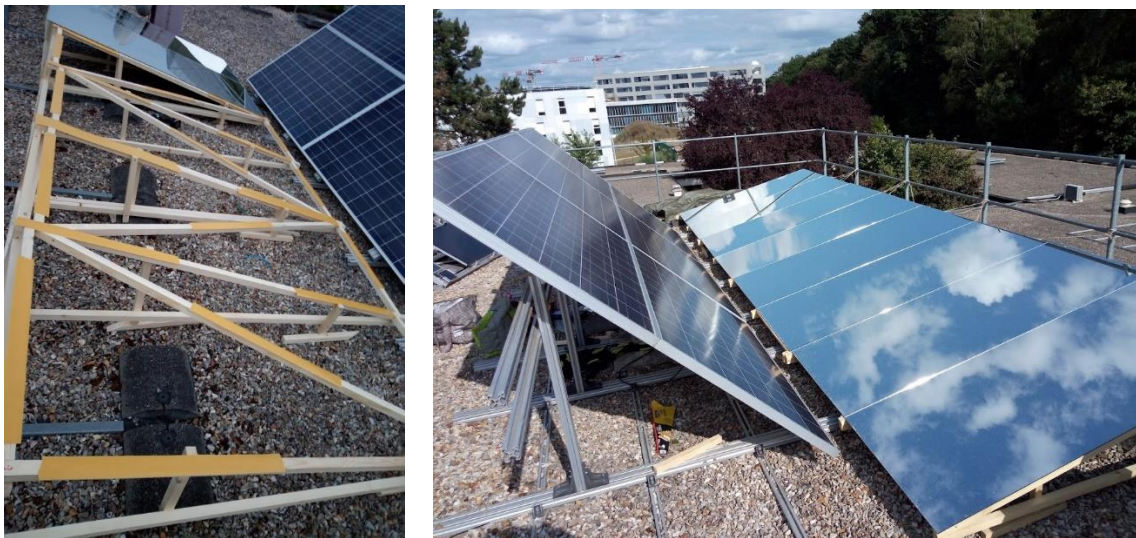
Figure 73 Vues du processus d'installation des réflecteurs plans à GeePSunSite (à gauche) et du résultat final (à droite) (Juillet 2019)
