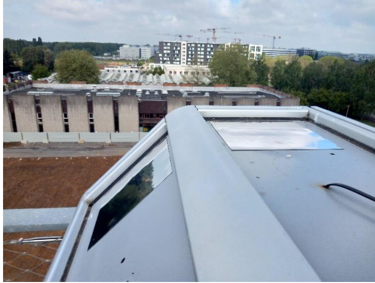
Figure 150 Installation des miroirs collants à l'observatoire SIRTA
