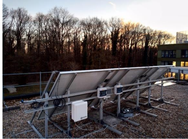
Figure 70 Vues des coffrets DC et AC, situés à gauche et à droite, respectivement, de l'onduleur et de la centrale d' acquisition Campbell sur la figure de droite (Février 2019)
