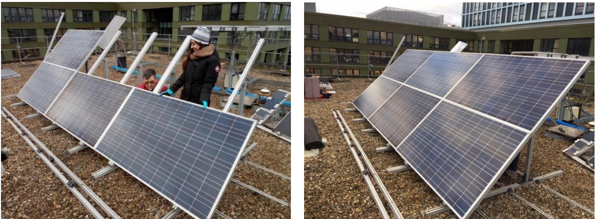
Figure 69 Photos lors de l'installation des panneaux photovoltaïques (Décembre 2018-Janvier 2019)
