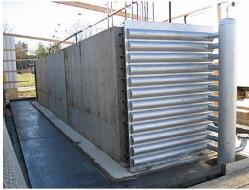
Figure 2 : Module de stockage utilisant le béton [14].
