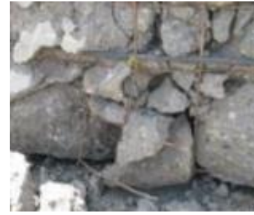
Figure 2.15 : État d'une barrière sans conception spécifique a) état général après des impacts multiples b) effritement localisé
