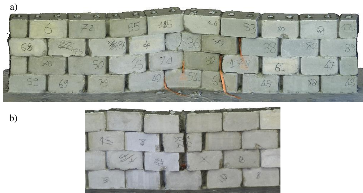
Figure 3.29 : Mur droit après impact à 1 040 J pour H_i = 0,5 m a) déformation générale du mur b) état du mur à l'arrière
