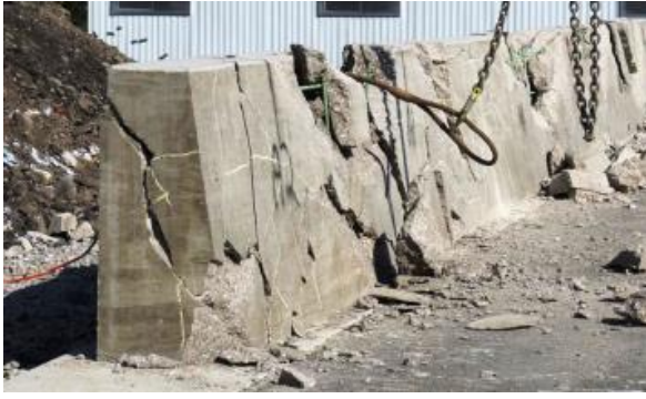
Figure 2.15 : État d'une barrière sans conception spécifique a) état général après des impacts multiples b) effritement localisé
