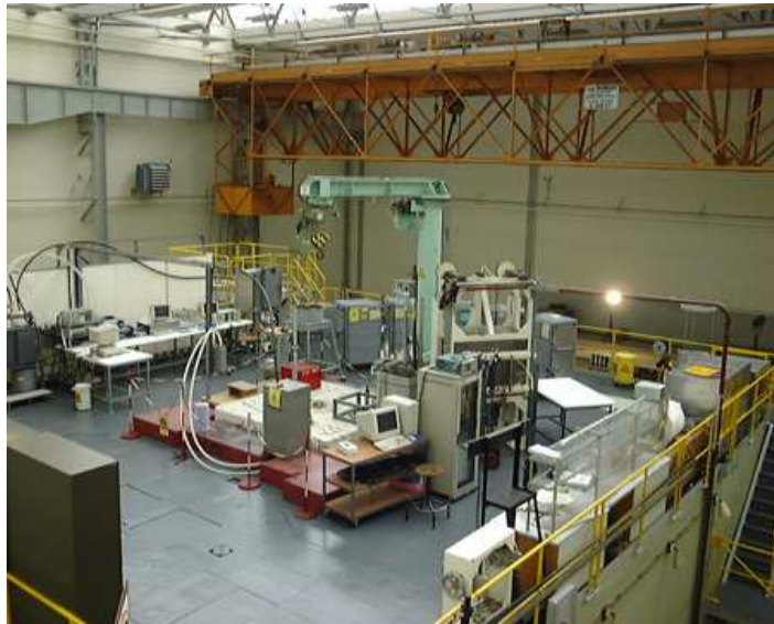
Figure A10.2 - Photographie du toit du réacteur BR1
