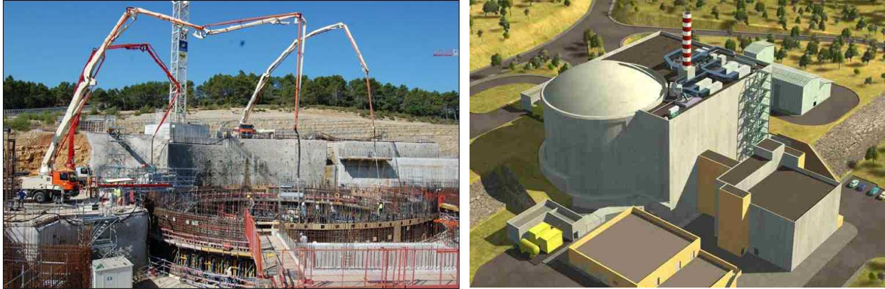
Figure 1.3 - Chantier du RJH (à gauche) et image de synthèse de l'installation terminée (à droite)
