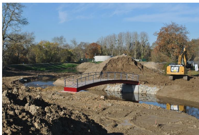
Figure 137. Création de méandres pendant les travaux de restauration (Saint-Mélaine-sur-Aubance, 19/11/2018, GP)
