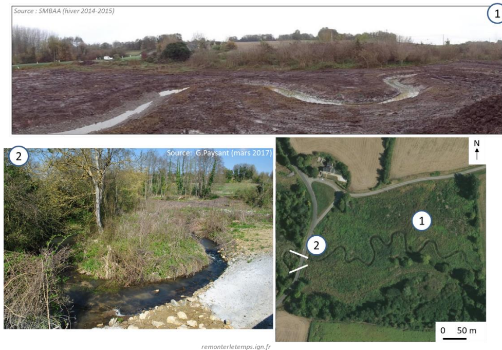
Figure 129. Travaux de renaturation sur le Couasnon (Sources : SMBAA, GP)
