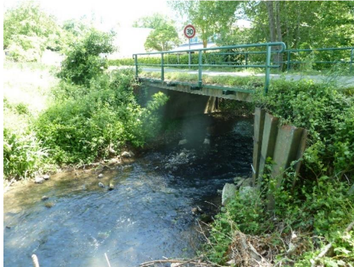
Figure 124. L'Aubance au moulin roux, visible en arrière plan (Vauchrétien, 14/05/2019, GP)
