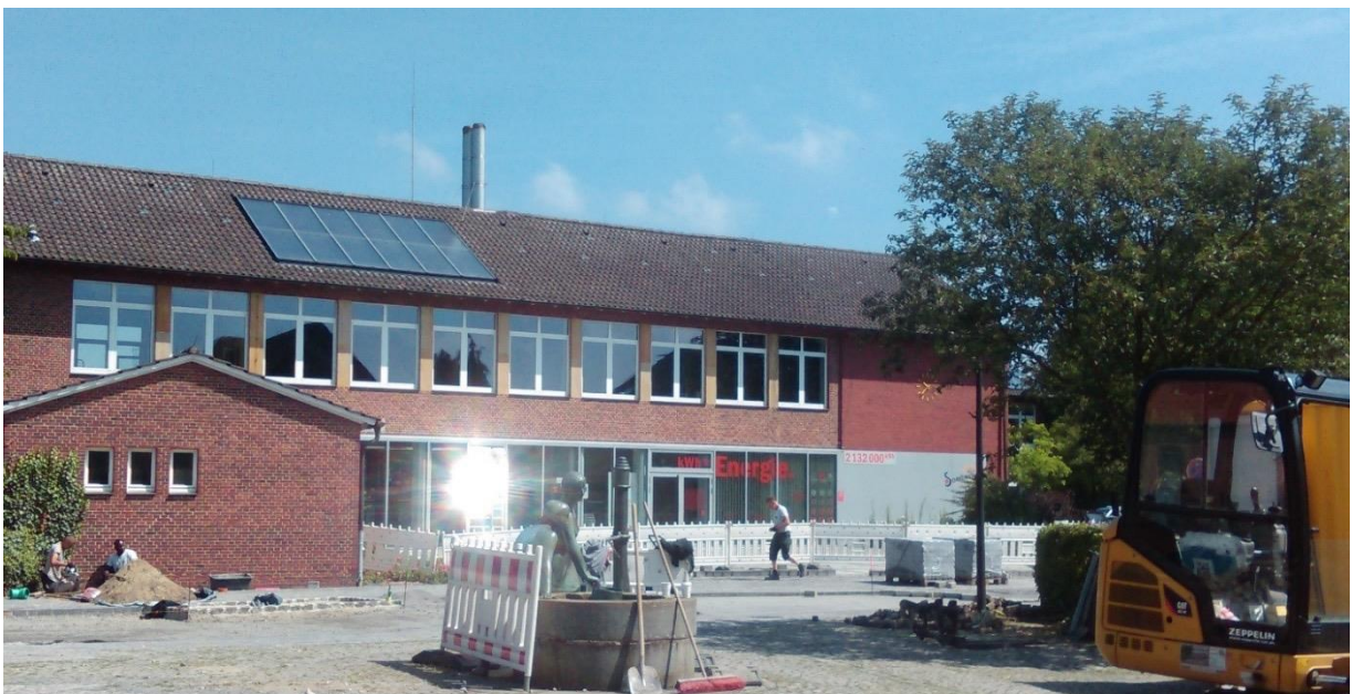
Figure 5.10: photo de la chaufferie centrale à Saerbeck (crédit photo : Flora Aubert)
