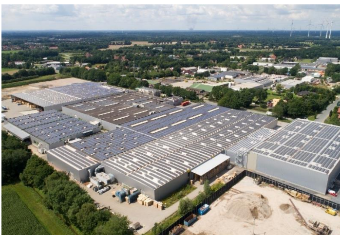
Figure 5.6 : vue aérienne de l’entreprise Saertex à Saerbeck (source : Saertex)
