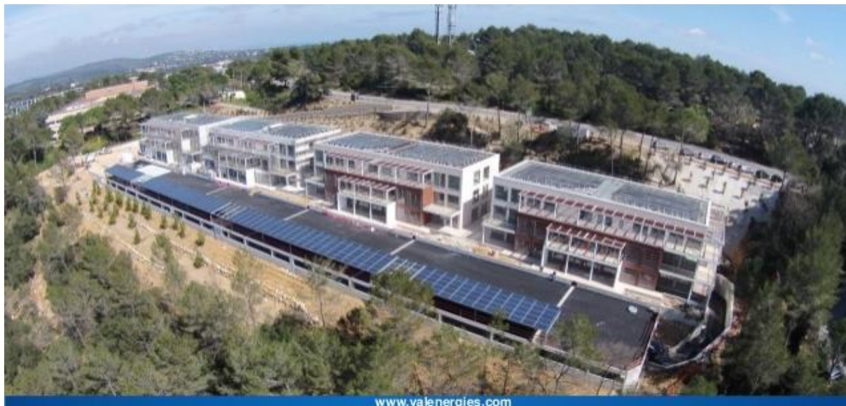
Figure 1.19 : vue aérienne du projet VolSophia (crédit photo : site internet de la société ValEnergies)
