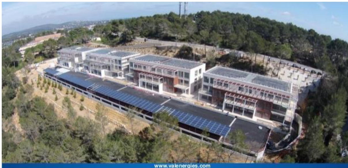
Figure 1.19 : vue aérienne du projet VolSophia (crédit photo : site internet de la société ValEnergies)
