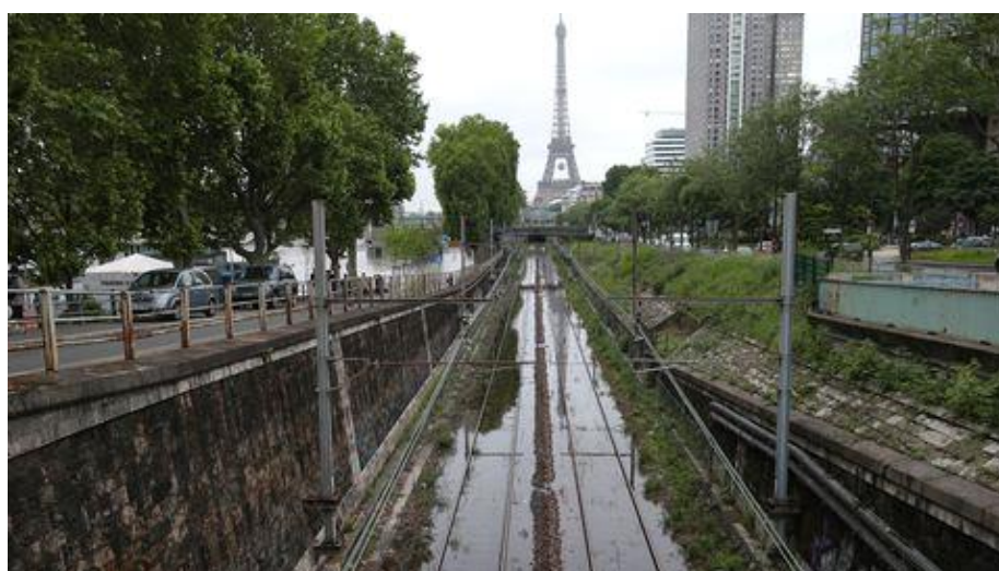
Figure 137 : Infiltrations sur les voies du RER C près de la station Javel. Crédits : Joel Saget / AFP.
