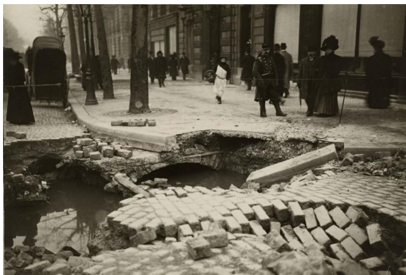
Figure 190 : Effondrement du boulevard Haussmann provoqué par la rupture du grand égout. Crédits : World's Graphic Press.
