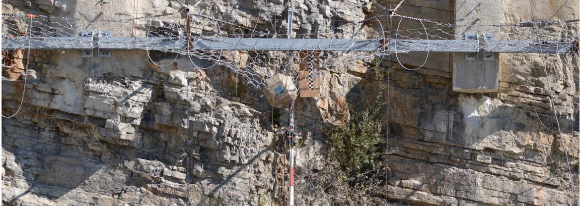
FIGURE 2.18 – Equilibre sous poids propre de l'écran et du bloc avant application de l'effort du treuil (source : C2ROP)
