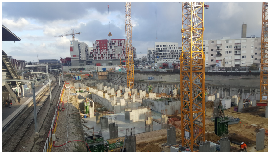
Chantier de l'Opération Cœur de Quartier, depuis la gare de Nanterre Université, photo prise en novembre 2017 par l'auteure
