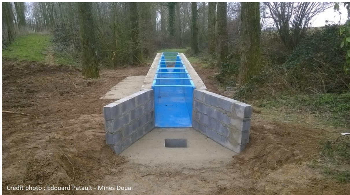
Fig. 74 : Canal Venturi à forme exponentielle, modèle ISMA taille VII.
