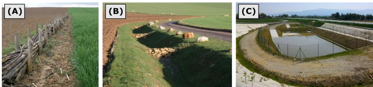
Fig. 3 : (A) Fascine (source : http://gerihco.engees.unistra.fr/fascines ), (B) Noue à redents en limite de parcelle (source : Yves Nédélec, CEMAGREF) et (C) Bassin de rétention à Méteren (Nord de la France) (source : http://www.charentelibre.fr/ )
