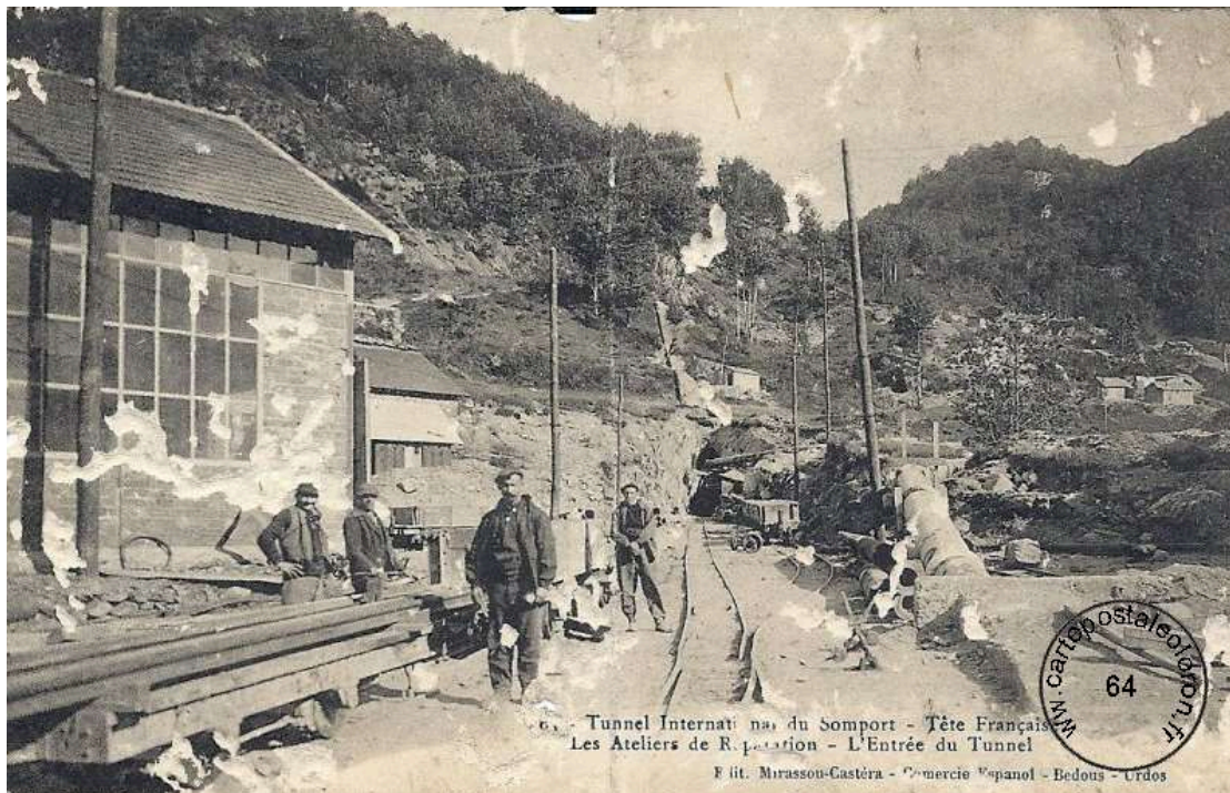
Photographie n°22 : chantier de percée du tunnel du Somport côté français.
