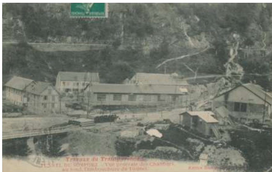
Photographie n°5 : vue d'ensemble du chantier d'entrée du tunnel du Somport côté français
