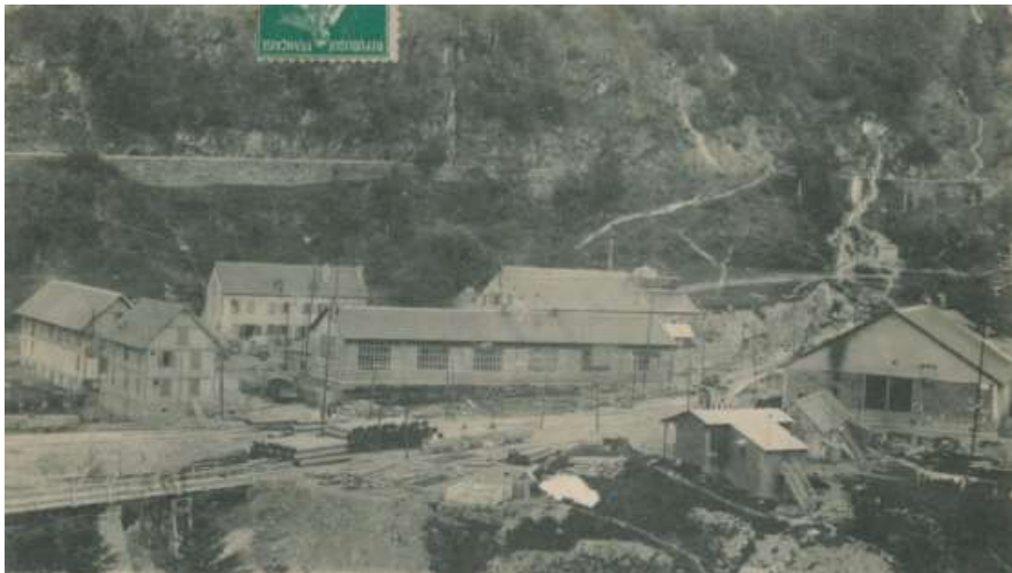
Photographie n°23 : vue générale du chantier du Somport en 1912.
