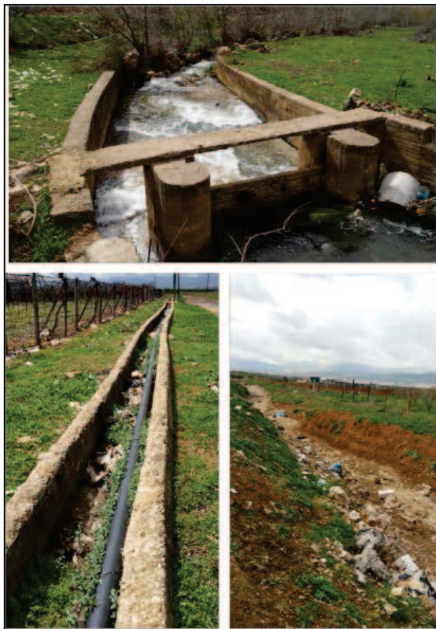
Figure 87 : Les systèmes d'irrigation de la zone de Ryak
