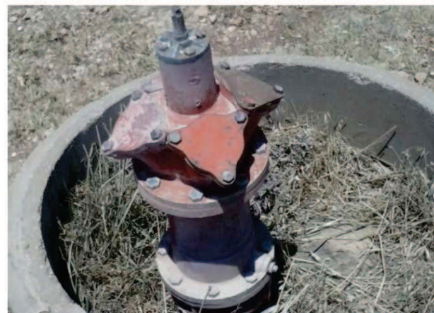
Une borne à quatre vannes de prélèvements
