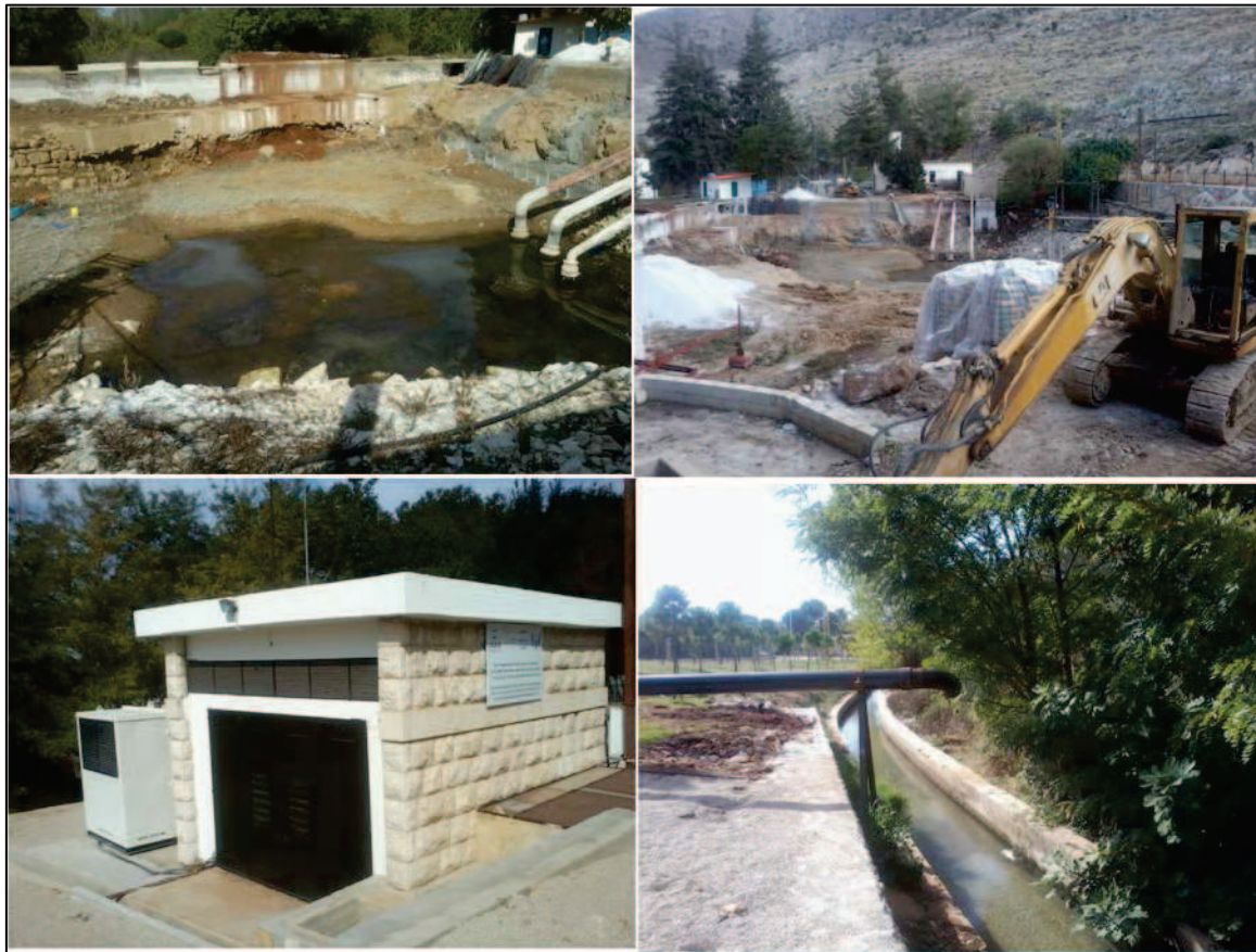
Figure 103 : Approfondissement du bassin d'Anjar et creusement de nouveaux forages
