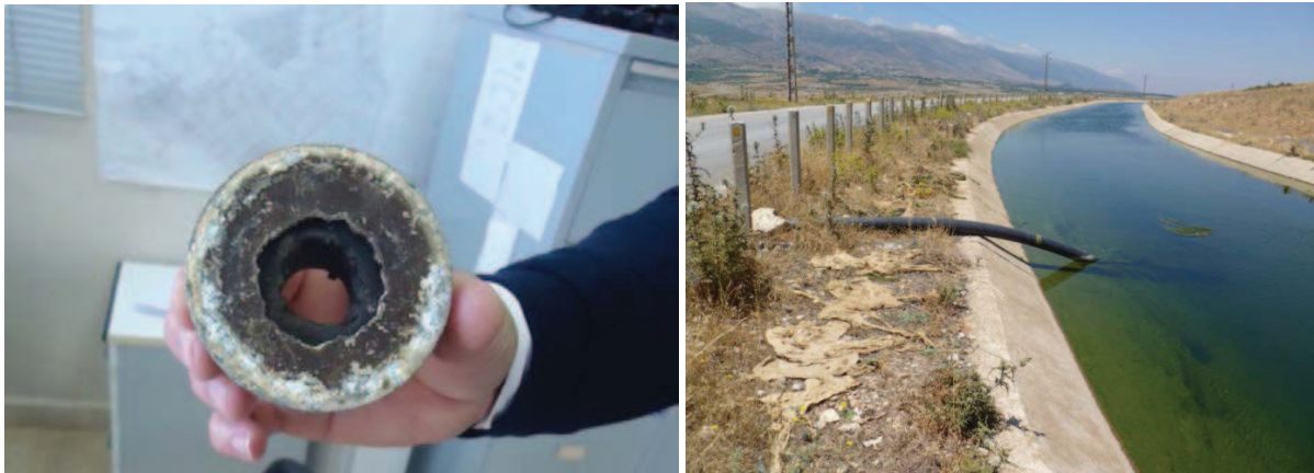
Figure 60 : Pratiques illicites (élargissement d'une valve) et tolérées (siphonage du Canal 900)
