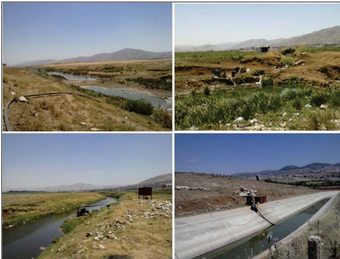
Figure 96 : L'utilisation du Litani et du Canal 900 pour stocker l'eau des forages
