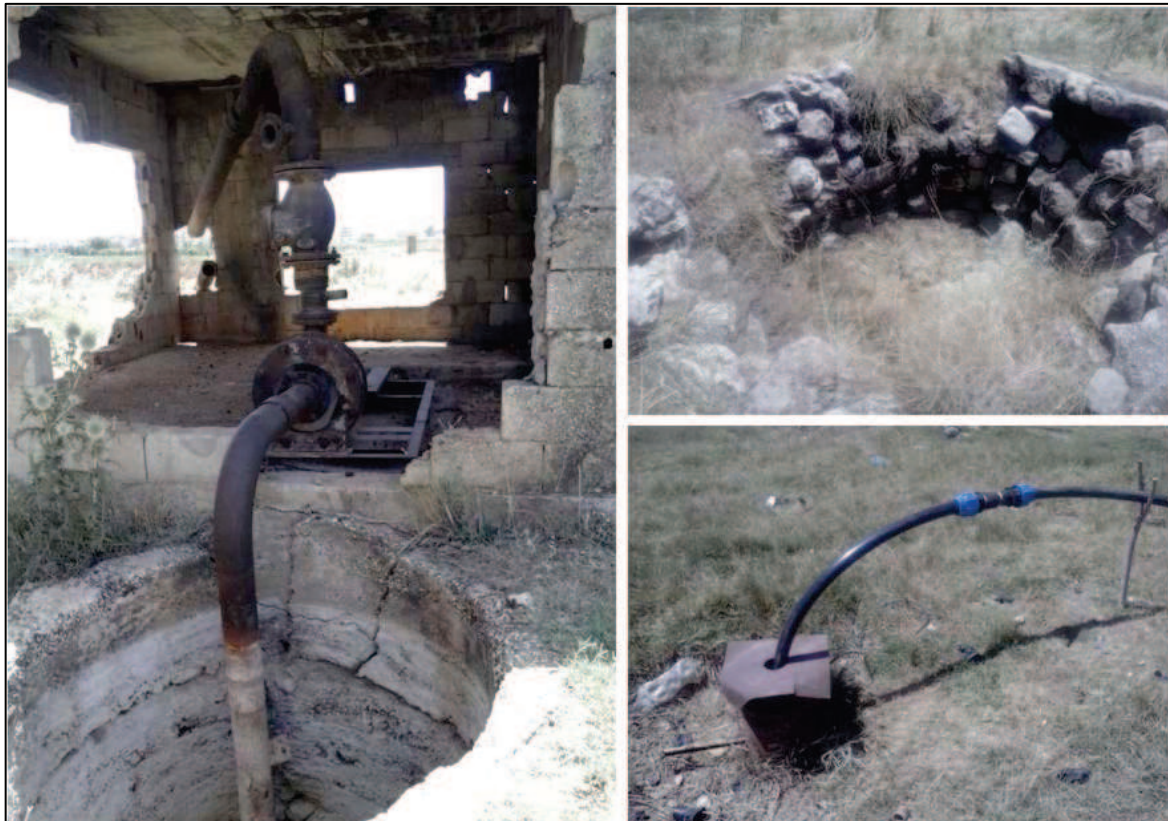
A gauche : un ancien puits superficiel asséché ; en haut à droite : un ancien « puits arabe » ; en bas à droite : un nouveau forage à pompe immergée. Source : Auteure, Békaa centrale.
