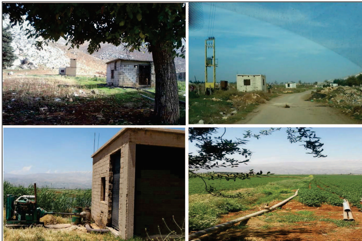
Figure 80 : Forages creusés dans l'aquifère Eocène à Terbol
