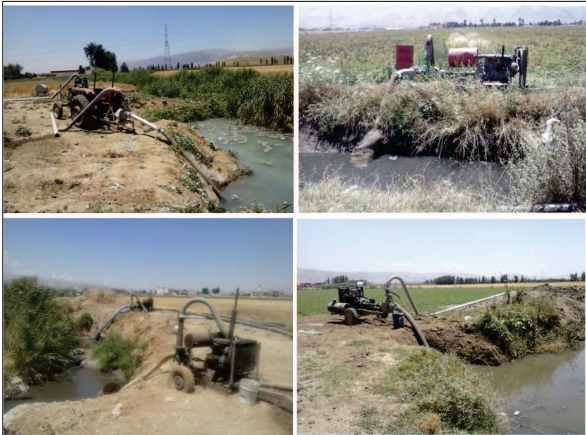
Figure 95 : Pompage de l'eau polluée du Litani pour l'irrigation à Barr Elias
