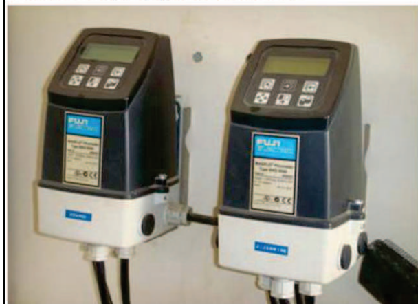
Les écrans de visualisation des débitmètres des branches de Joub Jannine et Kamed El Loz
