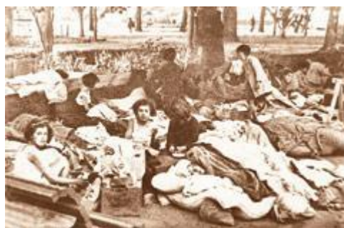
Figure 5 : Photo de l'après le tremblement de terre de 1939 166 . Les sinistrés s'organisent en dehors des dispositifs de l'État, la population des zones de catastrophe dort dans des endroits à ciel ouvert de peur des répliques du séisme.
