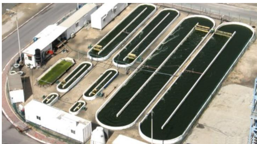
Figure 15 : Bassin de type « raceway » pour la culture de micro-algues (Seambiotic Ltd, Israël).
